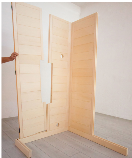
Fig. 6 : Insérer l'élément mural avec la découpe
