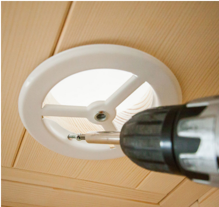
Afb. 17: Montage van de ontluchting
