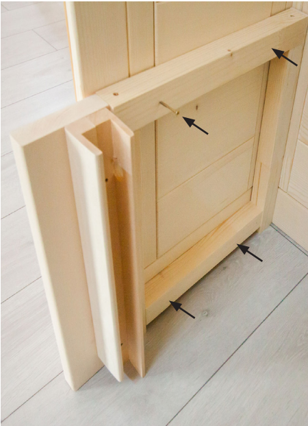
Fig. 18 : Monter les supports du banc
