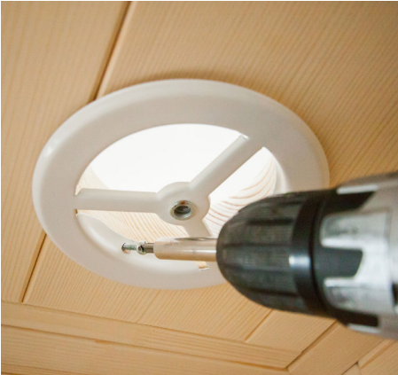
Abb. 17: Montage der Entlüftung
