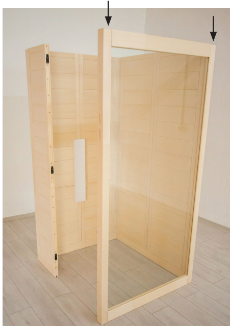
Abb. 10: Montage des Türrahmens
