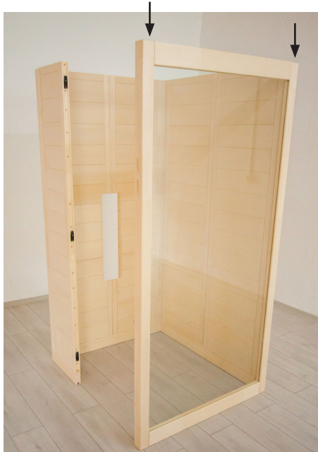
Fig. 10 : Montage du cadre de porte
