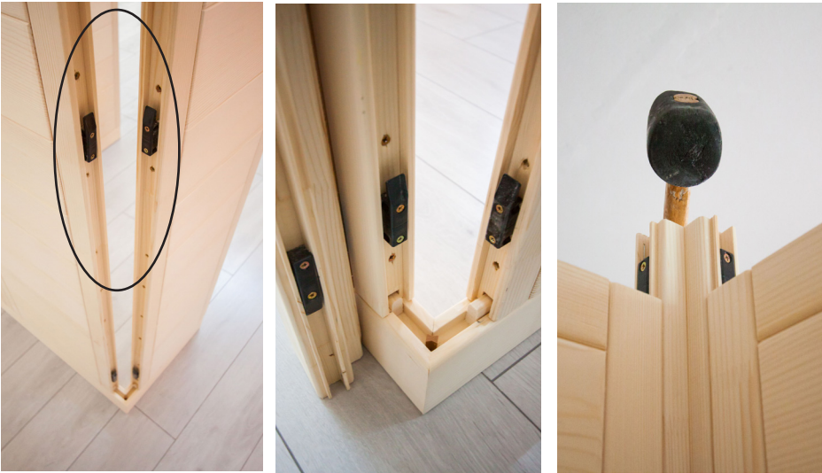
Abb. 4: Wandelemente mit Ecksteher verbinden
