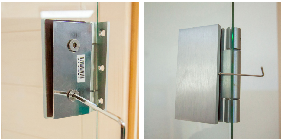
Fig. 32 : Montage des ferrures de portes 2
