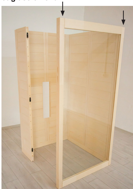
Afb. 10: Montage van het deurframe
