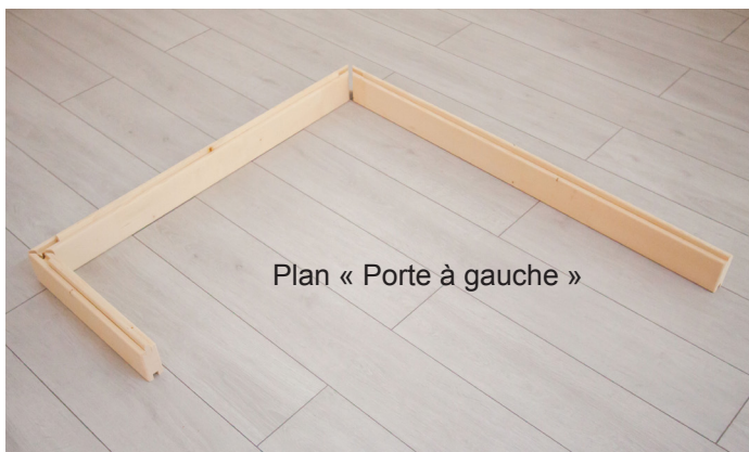
Fig. 1 : Pose des trois éléments de cadre de plancher
