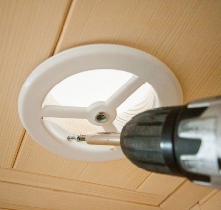
Fig. 17 : Montage de la ventilation
