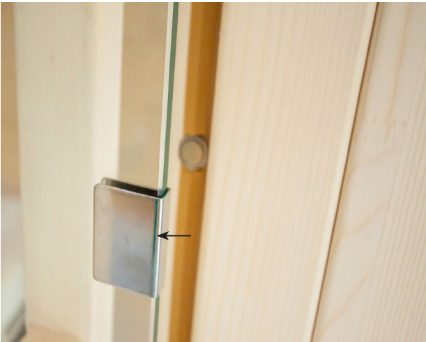
Abb. 35: Montage Überschub-Blech
