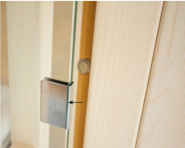
Afb. 35: Montage overschuifplaat
